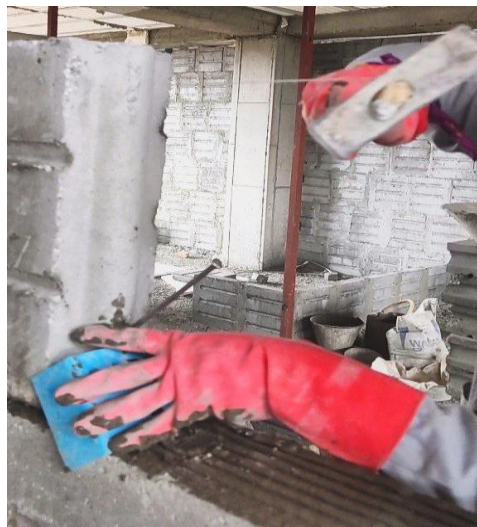
تصویر شماره 22: میخ کوبی بلوکها
