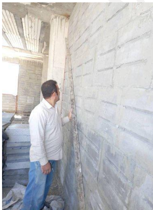
تصویر شماره 24: اجرای دقیق بلوک والا کس
