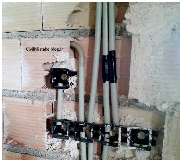
تصویر شماره 38 : درج تاسیسات در دیوار سفالی
