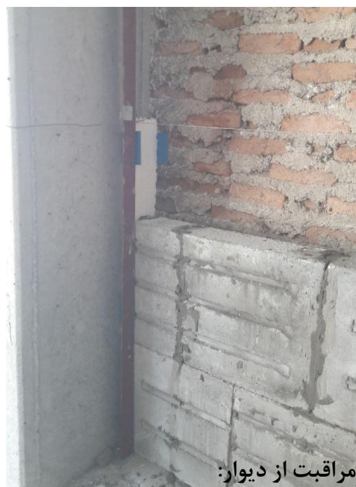
تصویر شماره 23: پلی استایرن بین سازه و دیوار
