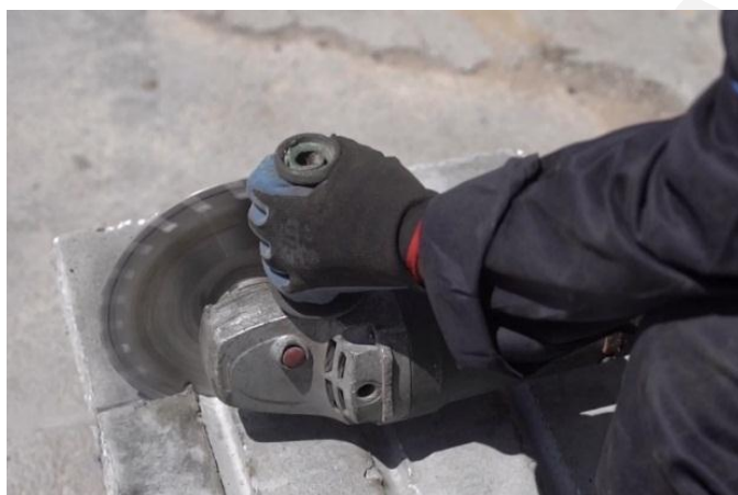
تصویر شماره 37 : برش بلوک والاکس با شیارزن
