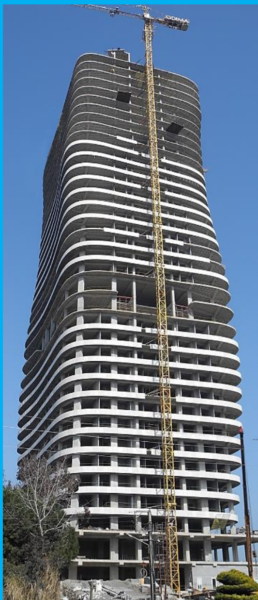
اجرای درای وال در برج مسکونی
