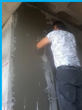
3- اجرای ملات و نصب مش
