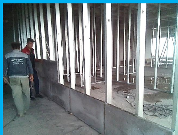
2- نصب پانل بر روی زیرسازی
