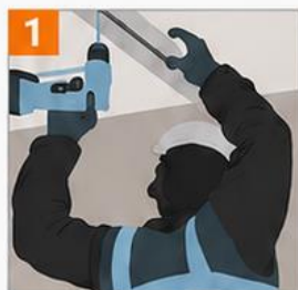
نصب رانر سقف
