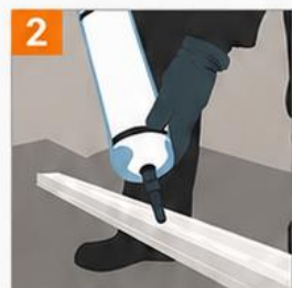
نصب رانر کف
