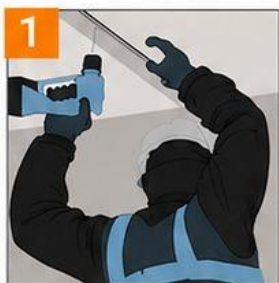
نصب رانر سقف
